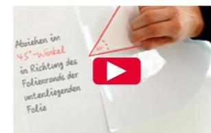
**ÜBERLAPPENDE VERKLEBUNG MIT DOPPELNAHTSCHNITT**
